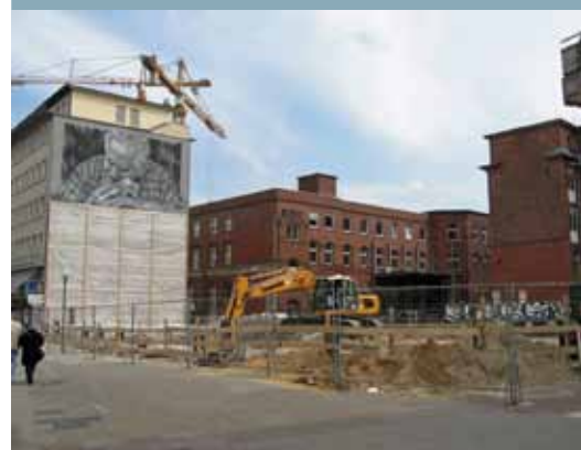
Baubeginn in der Neuen Großen Bergstraße 18
