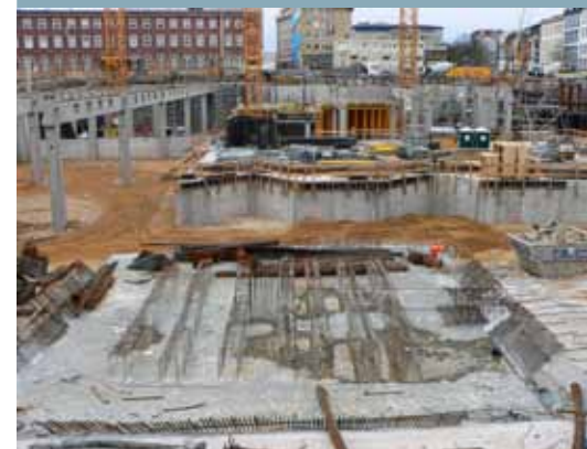
Arbeiten am Fundament des Gebäudes (Jan Moebus, IKEA Deutschland)
