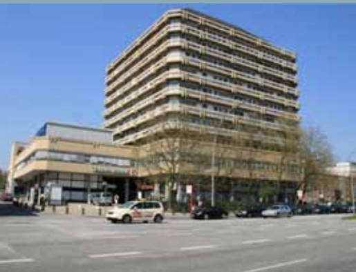
Die ENDO-Klinik vor der Modernisierung (Foto von 2006)
