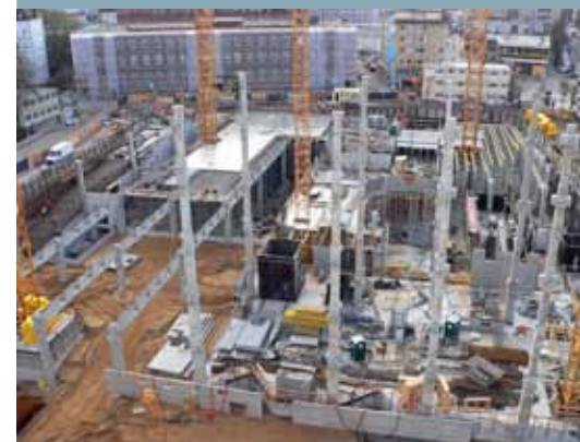
Blick in die Baugrube (Jan Moebus, IKEA Deutschland)
